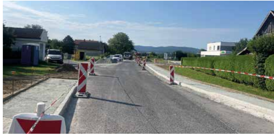
Die Bauarbeiten an den Gehsteigen zum ADEG sind bereits abgeschlossen.
